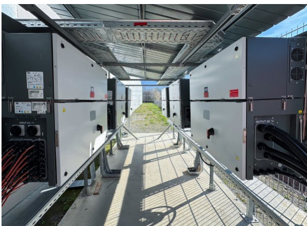
Solarkraftwerke auf dem Dach der Logistikhalle
